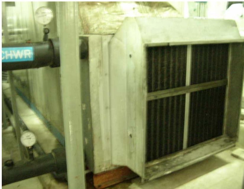
รูปที่ 2 เครื่องเติมอากาศพร้อมเครื่องลดความชื้นแบบ Solid Desiccant/Steam Coil : DH – C001
