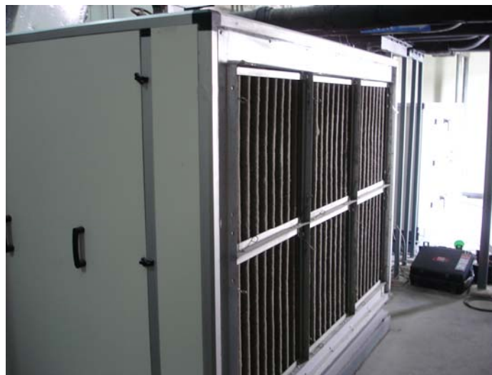
รูปที่ 3 เครื่องเติมอากาศ ซึ่งติดตั้งฮีทไปป์ เครื่องที่ 1
