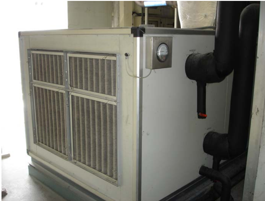
รูปที่ 4 เครื่องเติมอากาศซึ่งติดตั้งฮีทไปป์ เครื่องที่ 2
